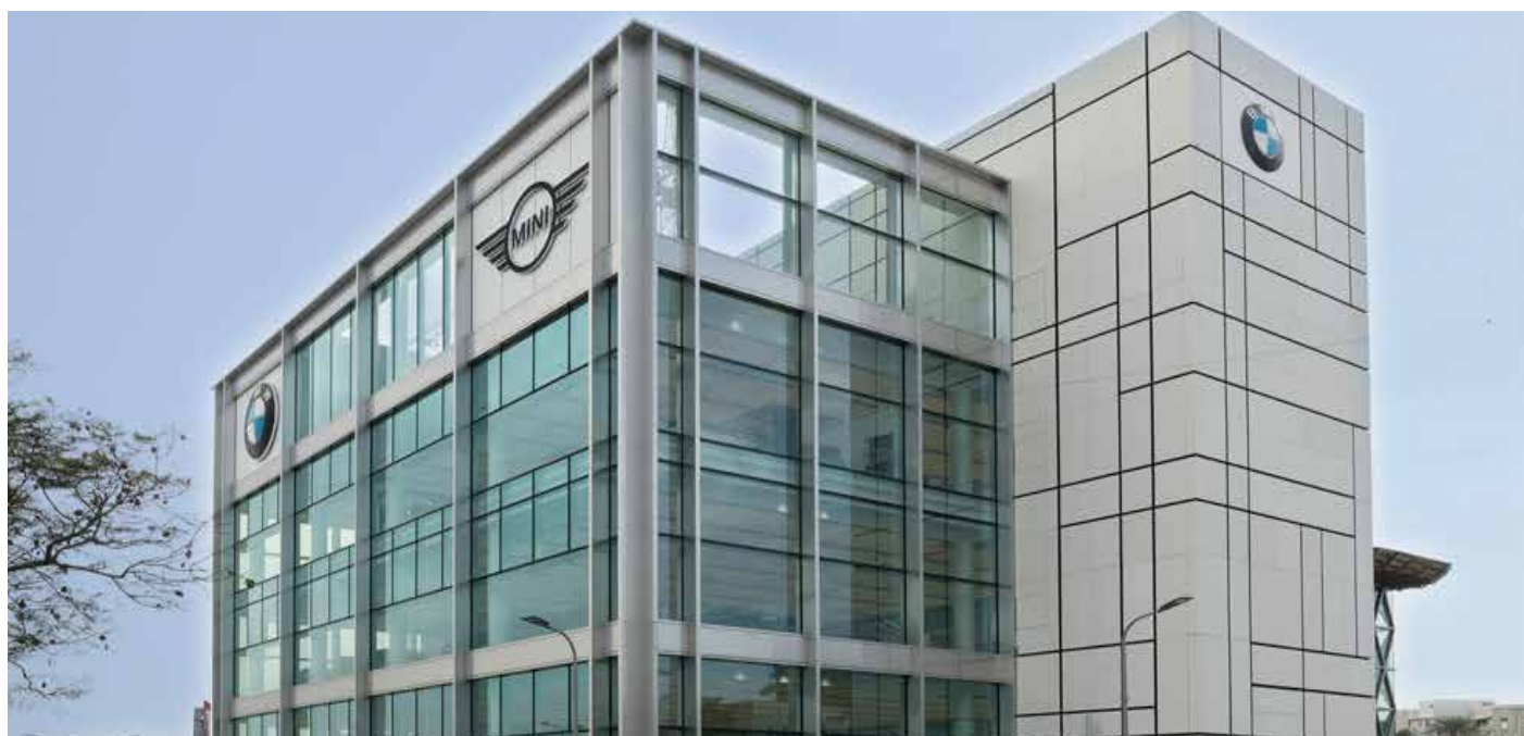
חיפוי UHPC, בניין BMW תל אביב, ישר אדריכלים.
