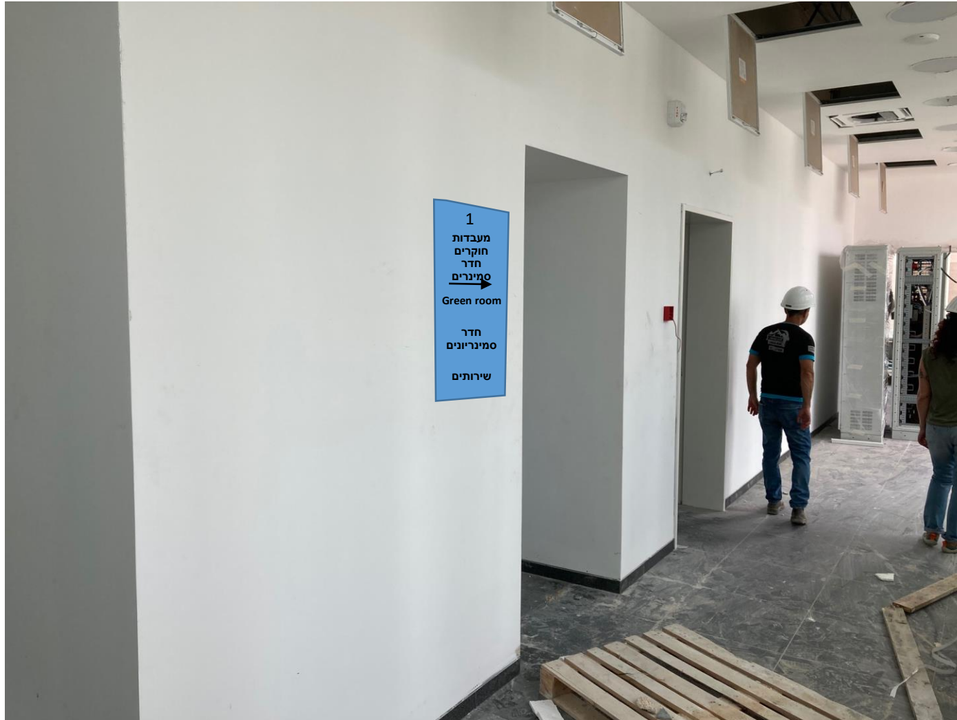
דיירקטורי מקומי – מפלס 1: משטח זכוכית מחוסמת 600*300*15 מ"מ (יש לוודא מידה מדויקת), כותרת + לוגו + מס' קומה בחיתוך אותיות + הדפס. עיגון אחורי לקיר.
